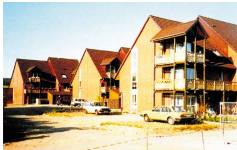
Neu errichtete Eigentumswohnungen in Hildesheim-Itzum, 1993 – 1994. Auch hier sind Holzbalkone aus Kostengründen vor die Fassade gesetzt worden.
