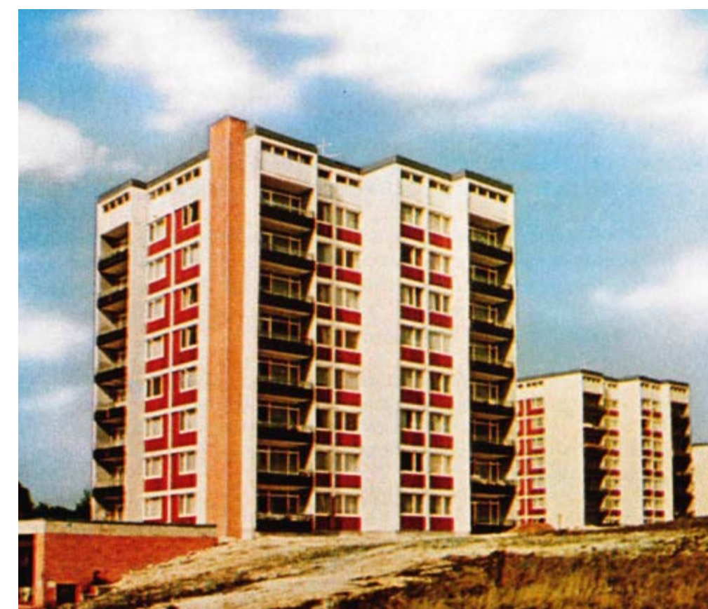
Die ersten Fahrstuhlhäuser der kwg, errichtet auf dem Hohen Kamp in Sarstedt, 1965. Auf neun Etagen je Gebäude wurden 16 Drei- und 16 Zwei-Zimmer-Wohnungen angeboten.
